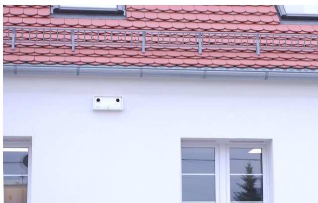
Fot. 22. Przykład montażu trocinobetonowej budki dla wróbli w warstwie izolacyjnej.
