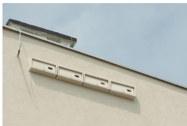
Fot. 23. Przykład montażu trocinobetonowych budek dla jerzyków w warstwie izolacyjnej.
